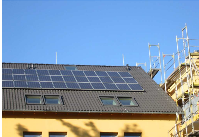
Aufdach-Teildachbelegung, Rather Broich, Düsseldorf
