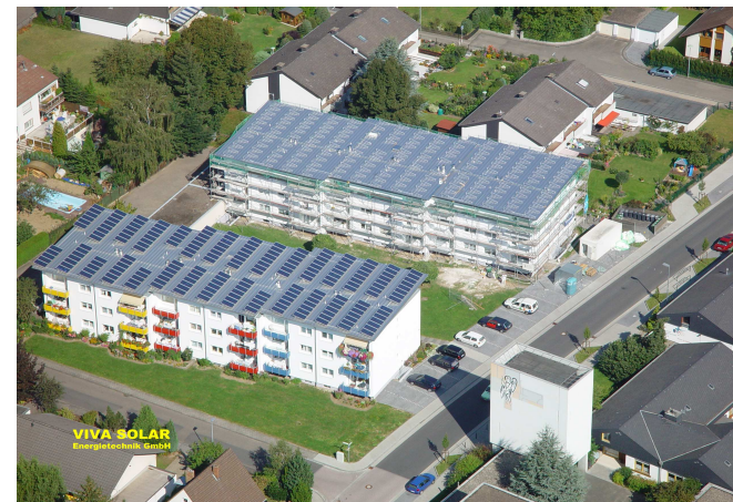
Flachdachaufständerung, Fahrer Straße, Neuwied
